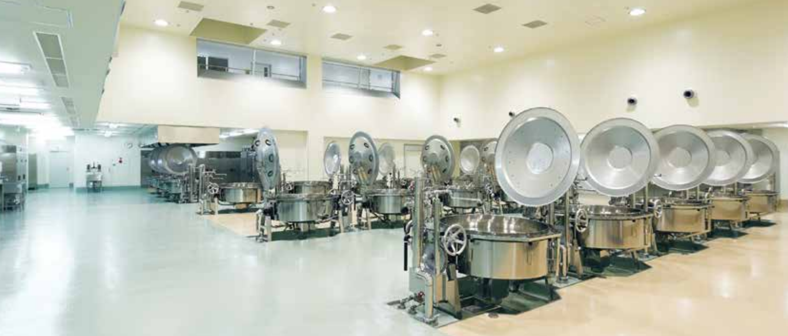
床の塗装でゾーニングされた調理室
